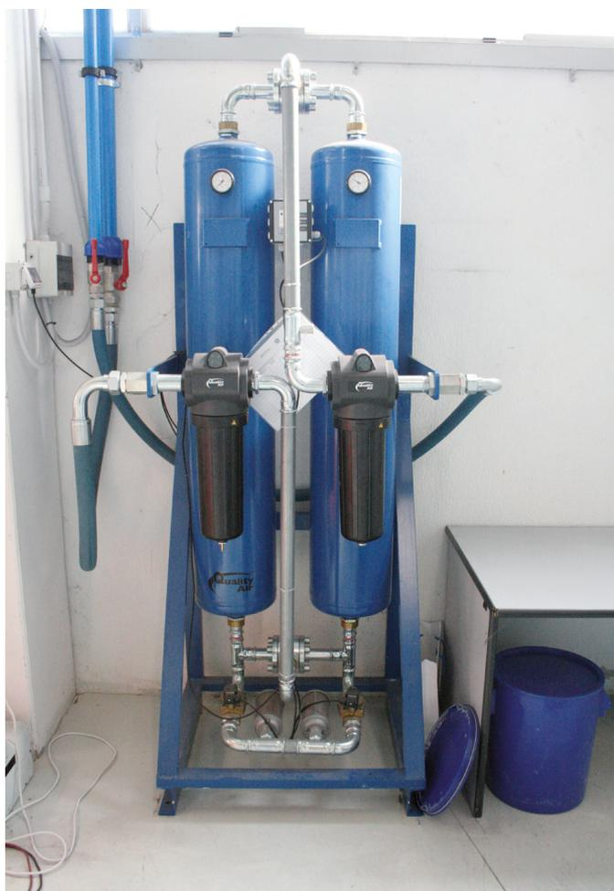
**17 – Il sistema di depurazione e disidratazione fine dell'aria compressa proveniente dal compressore.**
